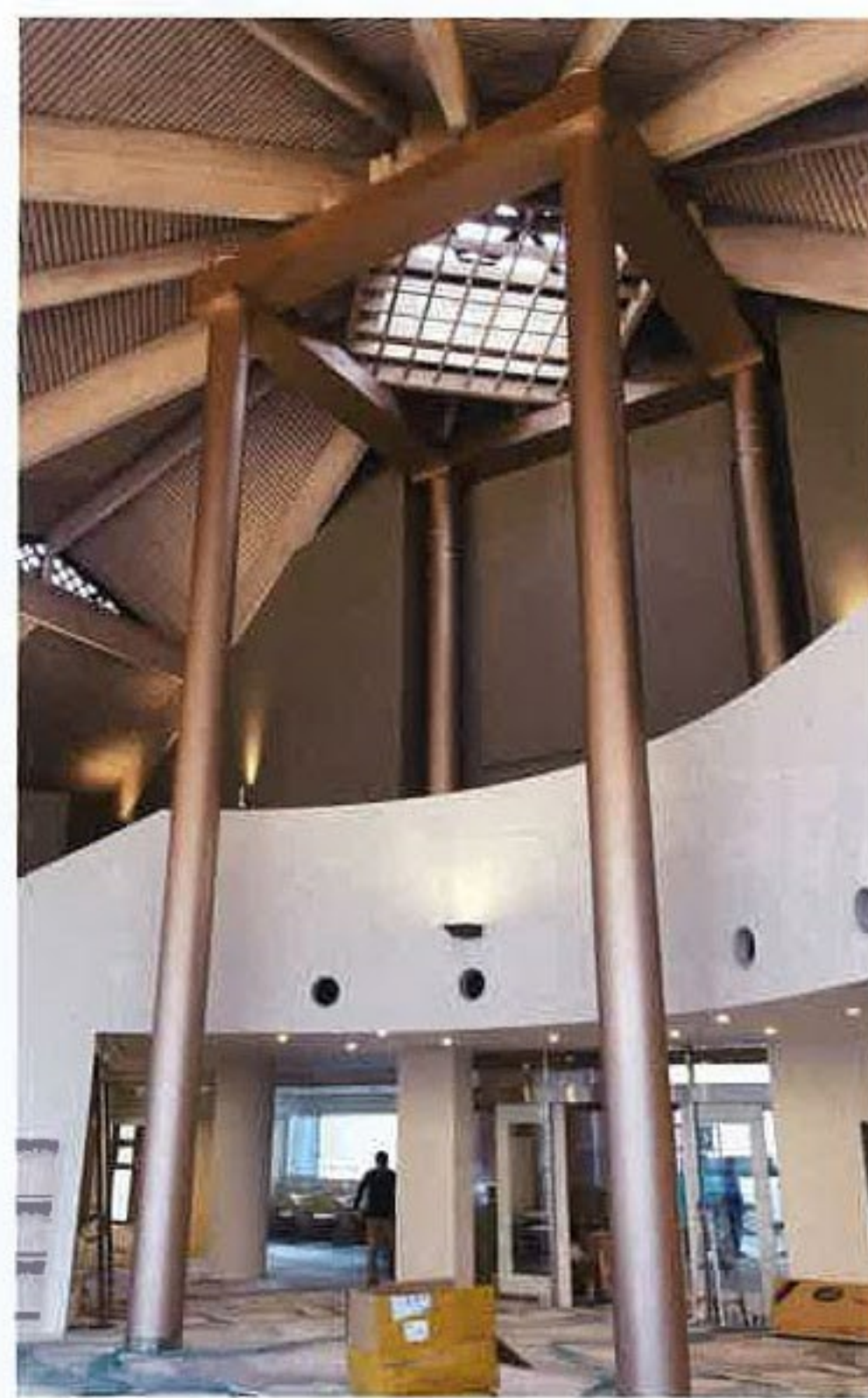
施工後。メタリックに輝く円柱
